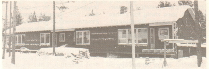
Byggingen av trygdeboligene på Prestmosen er i god gjenge. Bildet viser den ene halvdel av byggene, som nå nærmer seg slutføring. I alt blir dette en tilvekst på åtte boliger, som ligger nær opp til de tidligere trygdeboligene.
