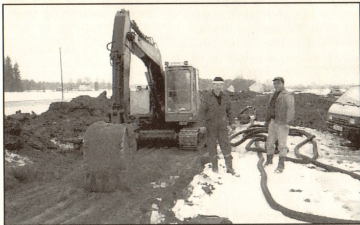
Store anleggsarbeider pågår nå ved legging av hovedvannledningen fra Moreppen til Preståsen. Her anført av gravemaskinkjørerene Per Steinar Havn og Torfinn Enderud i Gardermoen Anlegg.
