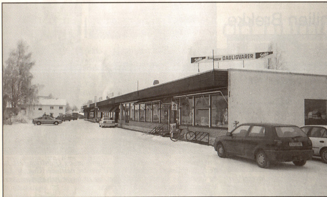
Sentrumsgården i Maura, som sammen med det tilliggende området skal reguleres til forretningsformål.
