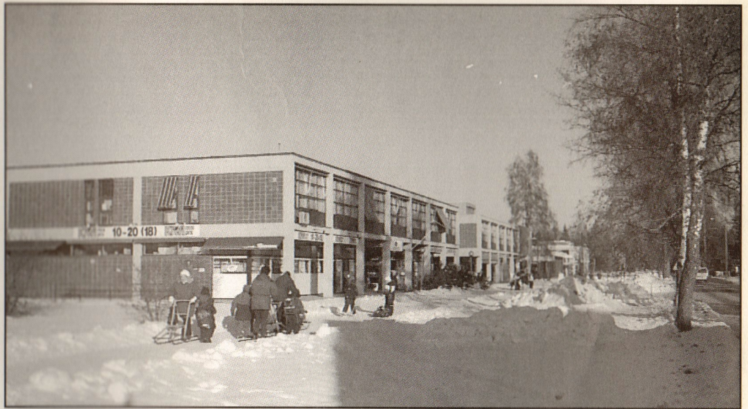
Granåsgårdene, Sparebanken NOR og Nordengenbygget vil også i fremtiden utgjøre en kjerne i Nannestad sentrums utforming.
