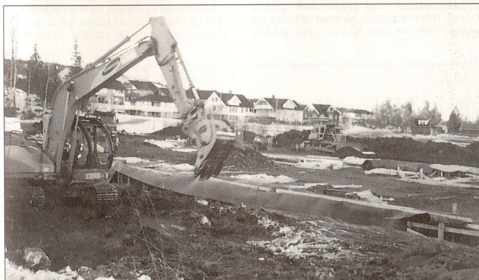
Slik så anleggstomta på Eltonåsen ut i midten av februar.
