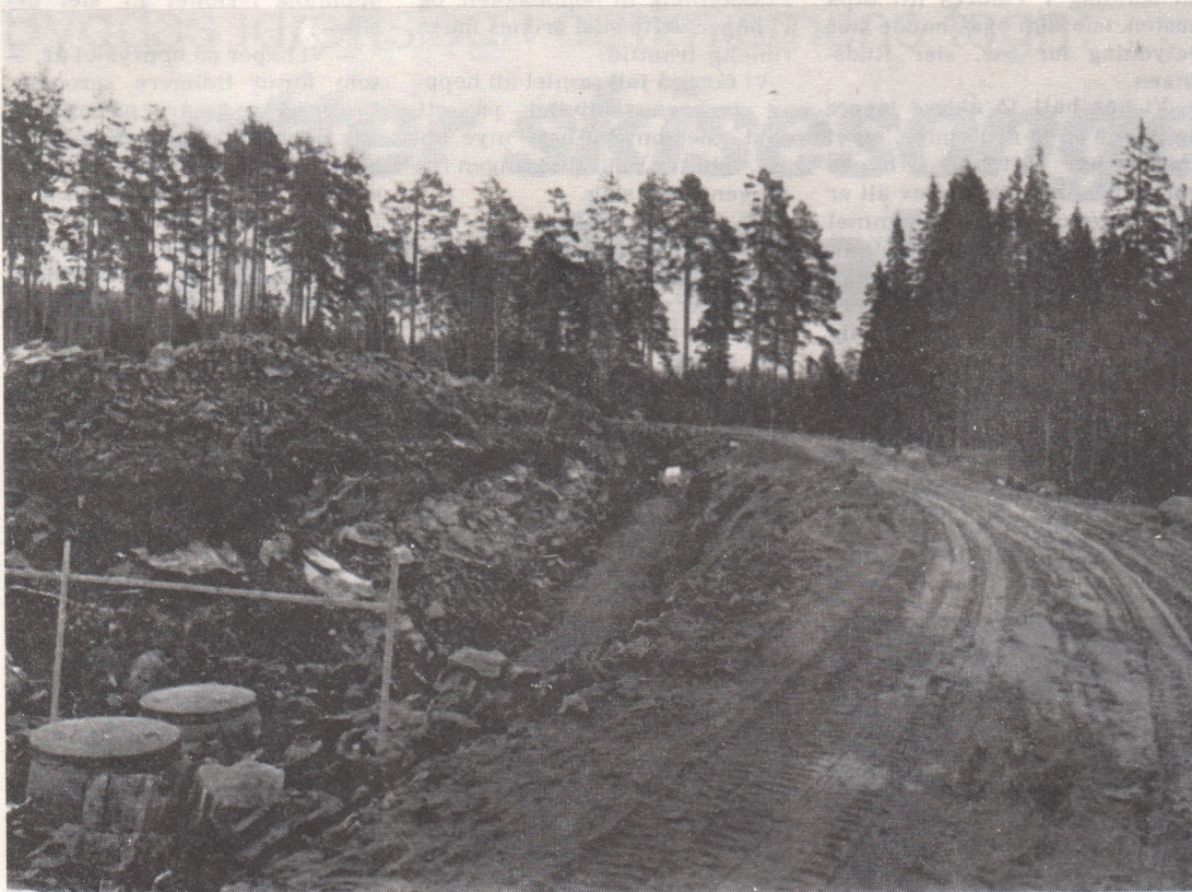
Fra Holkebylia, der arbeidene med vann, veg og kloakk til de første byggetomtene pågår.
