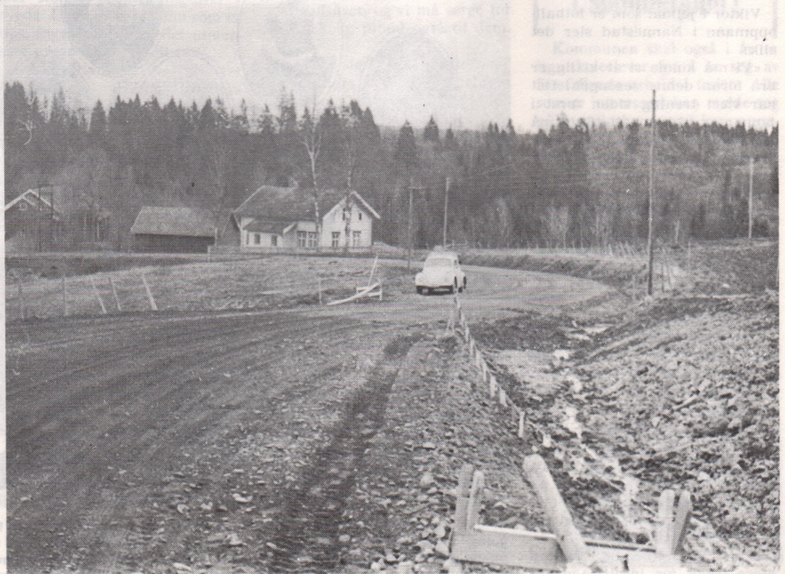
Betydelige utbedringsarbeider pågår. Her fra Åsvegen ned mot Kringlerdalen.
