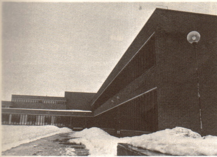
Kommunehuset vil trenge påbygging i planperioden.
