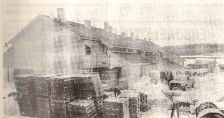
Fra boligreisningen i første byggetrinn av Gullbekken borettslag.
