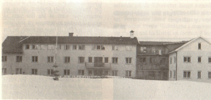
Fagerli sykehjem har i ett år gjennomgått omfattende ombygningsarbeider. Over fem millioner kostet ombyggingen, som blir avsluttet i løpet av 1987.
