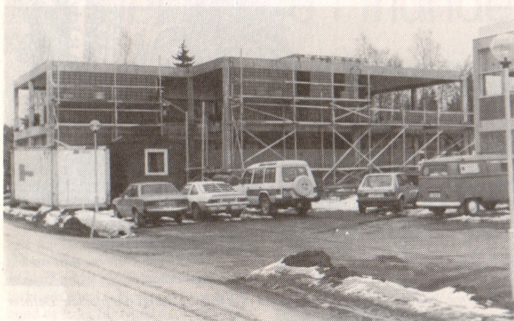
Det nye forretningsbygget i Nannestad tar form.
