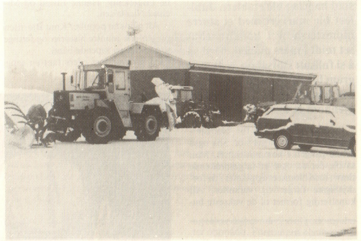
Uteseksjonens nye kaldtlager i tilknytning til garasjeanlegget i Bahus.
