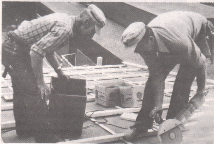
Arnt Edseth og Erik Åsheim i takarbeide på Løken skole.
