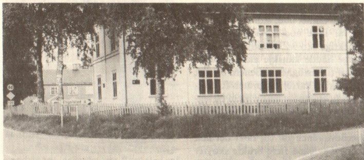
Her starter Engervegen, ved det gamle kommunehuset.
