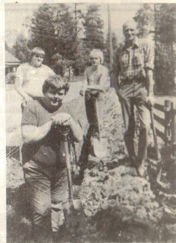
Fra leggingen av telekabler i Preståsenområdet.
