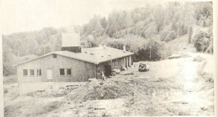
Holter renseanlegg ligger mellom veien og Leirelva like nord for Krokfoss.
