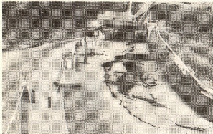
I juni raste veien i Holterdalen nesten en meter rett ned. Over en måned og 700.000 kroner tok det å utbedre skaden.
