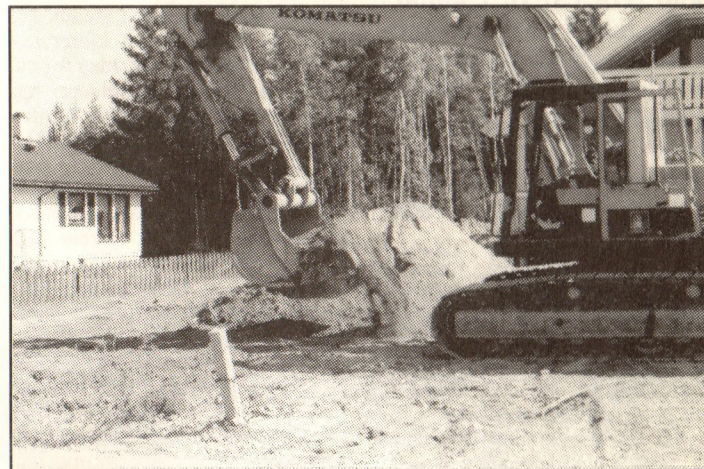
Entreprenørfirmaet i full gang med fremføring av kloakknettet til Preståsen 9.
