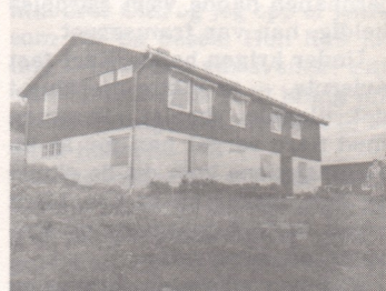
Nytt våningshus er reist i Burås Nedre, med generasjonsbolig i underetasjen.
