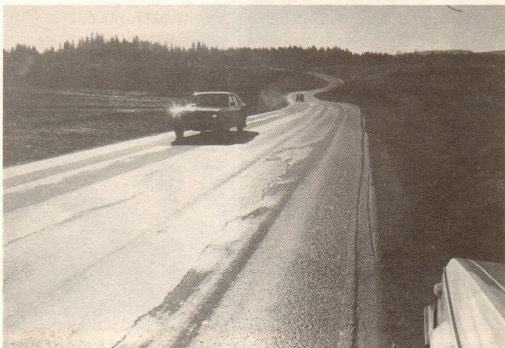
Dagens veger i bygda har i de senere årene gjennomgått store forbedringer.
