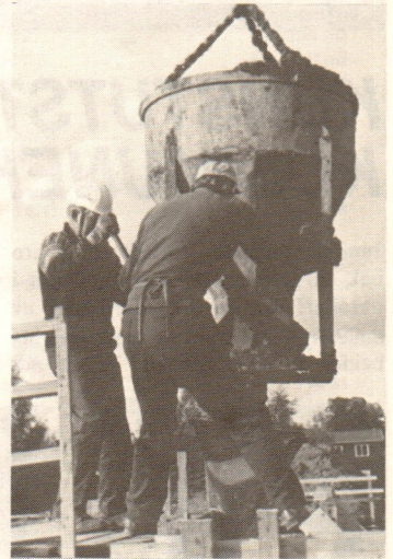
Støyping av grunnmur pågår.
