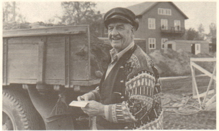
Ragnvalg Kjærstad, lastebileier og pensjonist, i ferd med sandkjøring på byggeplassen.
