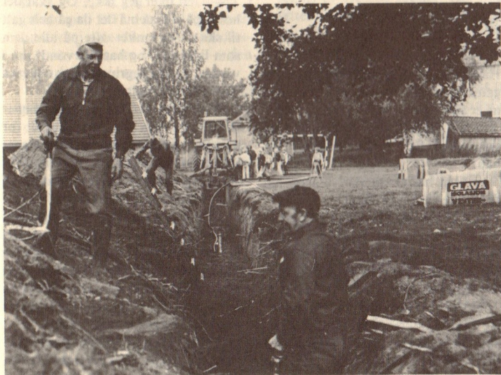
Rørene er lagt, og Nordahl og Burås er klar for gjenfylling.
