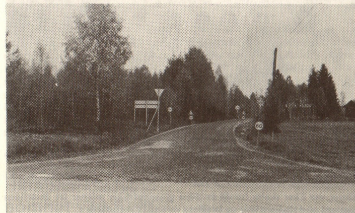
«Promillevegen» blir nå bedre å kjøre på.
