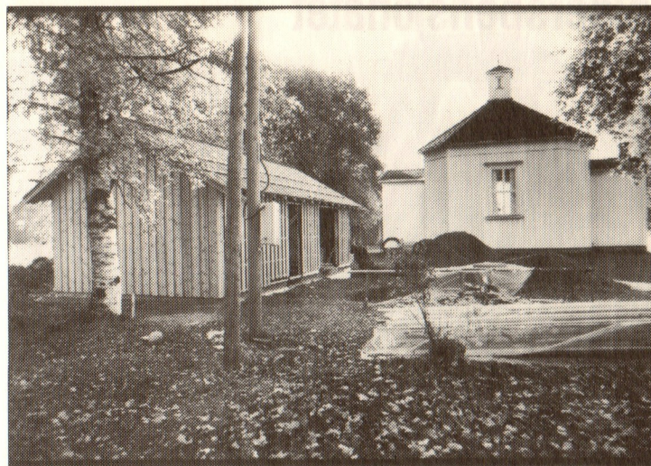
Nybygget ved Holter kirke skal stå ferdig ved årsskiftet.
