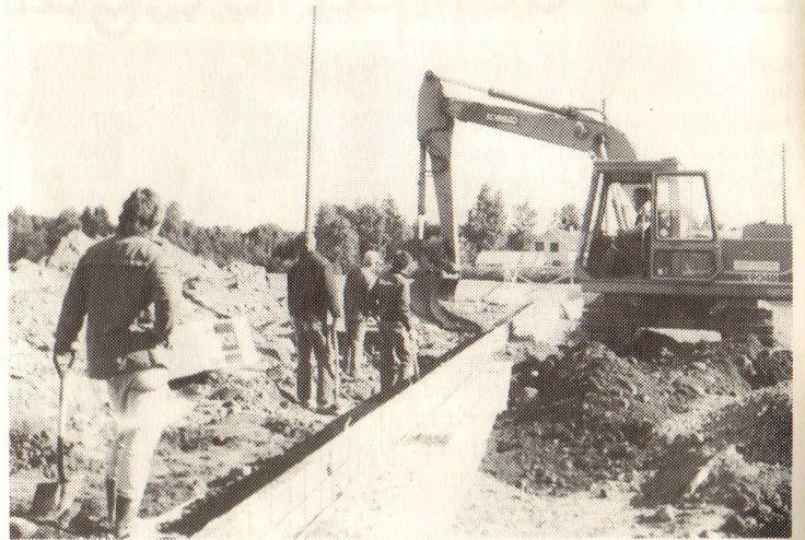
Isolering og påfylling av masse er utført på dugnad.
