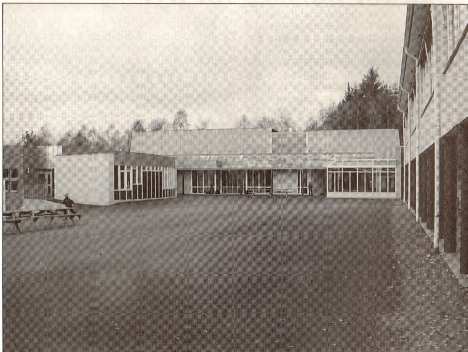
Maura skoles nye tilbygg slik det tar seg ut fra skolegården.
