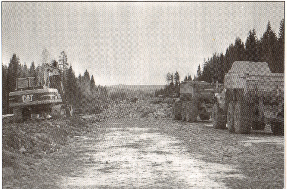
Anleggsarbeidene pågår for fullt ved Slettmoen.
